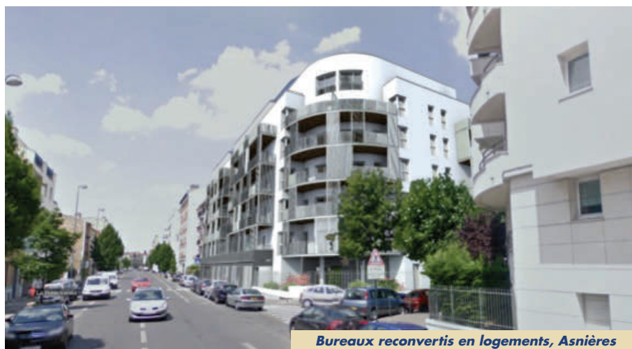
Bureaux reconvertis en logements, Asnières
