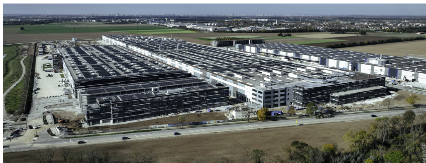
VGP Park Munich : plus de 300.000 m 2 de bâtiments éco-efficaces et de technologies innovantes avec une capacité d'énergie solaire de 11,5 MWC sur les toitures
