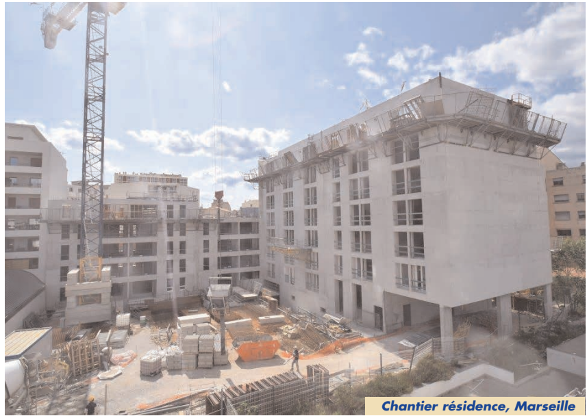
Chantier résidence, Marseille
