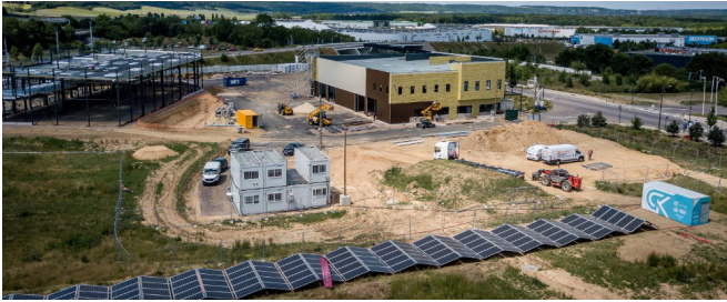
Chantier du Parc Spirit du Mantois - Buchelay (78) - EPAMSA Anne Carcelen Architecture
