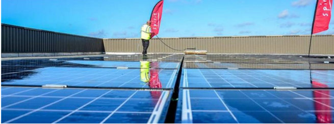
Nettoyage des panneaux photovoltaïques installés sur le Spirit Business Cluster de Tremblay-en-France (93)
