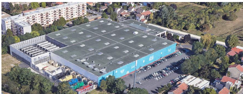
Data Center - 11.373 m 2 achetés par NJJ à Vitry-sur-Seine fin 2020 (Transaction CBRE).
