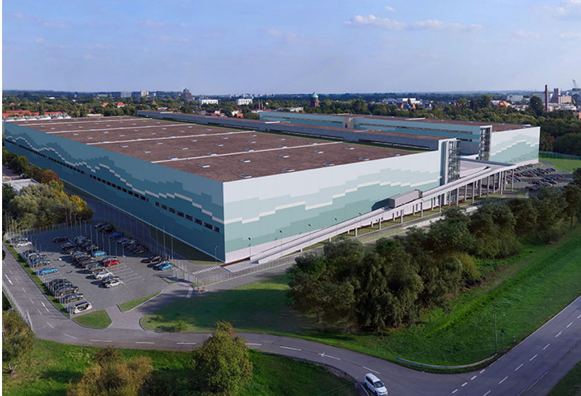
Nouvelle plateforme logistique multi-niveaux de 123.000 m 2 en cours de construction pour Four Parx, Allemagne.
