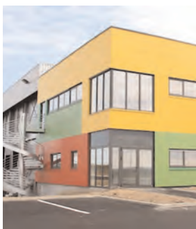
Coopérative Scaffla Ancenis
