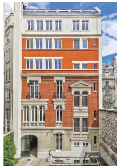
Immeuble 23 rue Boissière, Paris 16
