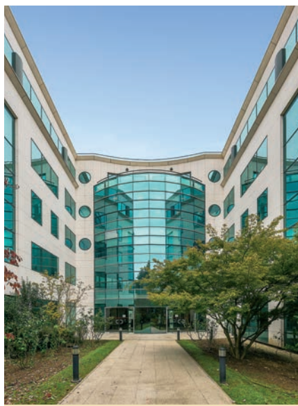
Vauban à Vélizy : 7 000 m 2 de bureaux
