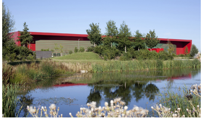
Coudray-Montceaux (91) - Parc logistique des Haies Blanches de 320 000 m 2
