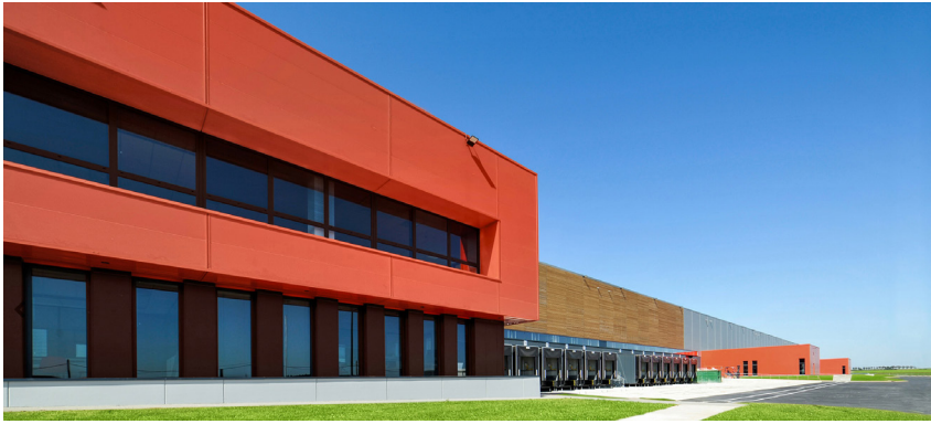
Louvres (95) - Plateforme logistique de 28 162 m 2
