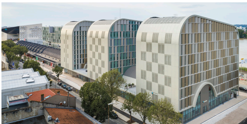
La Halle Boca à Bordeaux
